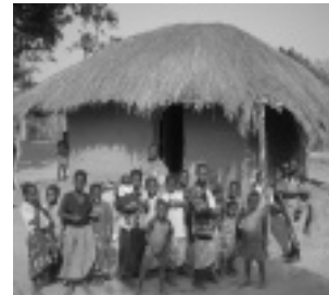
茅葺き屋根に土壁の、マラウイの一般的家屋
