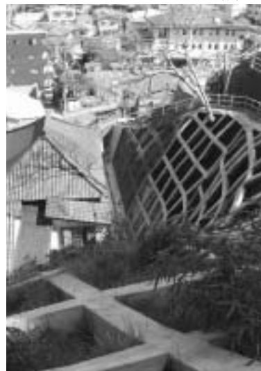
昨年度施工の古奈地区急傾斜地崩壊対策事業
