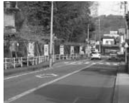
古奈交差点付近の歩道改良工事実施区間
