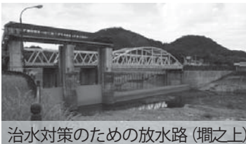
治水対策のための放水路(堰之上)
