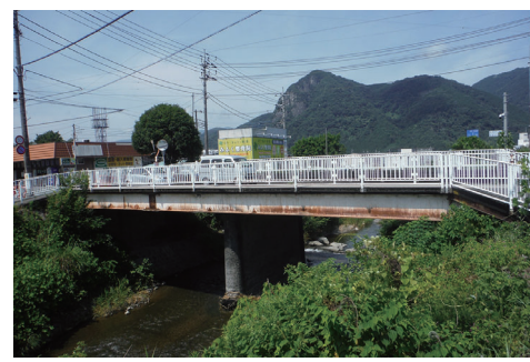
▲現在の深沢橋
