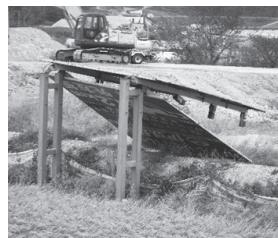
▲ 破損した看板
