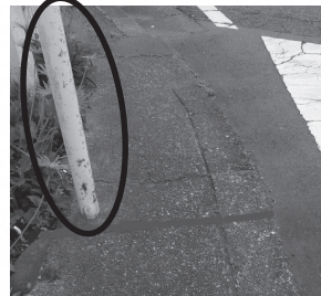
▲標識柱を移設して歩行スペースを確保
