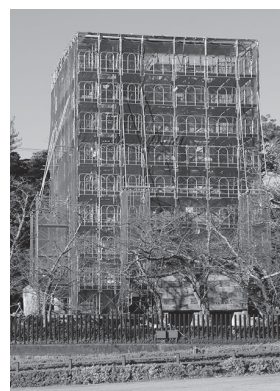
工事中の様子
