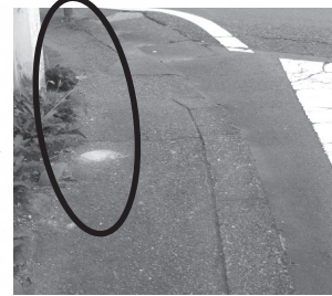
▲標識柱を移設して歩行スペースを確保
