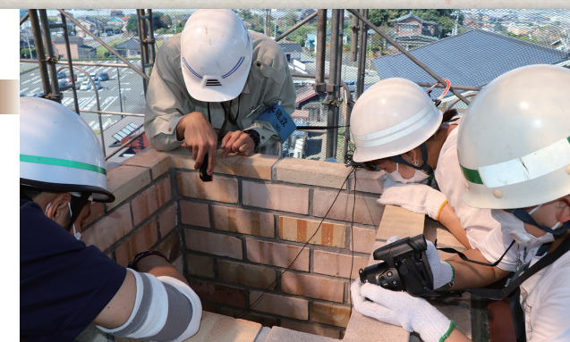
最上部から煙突内部をのぞく
