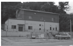
建設中の新しいし尿処理施設
