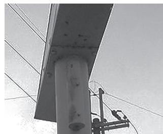
▲さび色の水が垂れたような跡 (内部が腐食しているかも)
