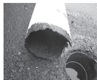
▲柱根元のさび (折れて倒壊するかも)
