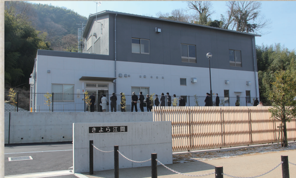
完成した伊豆の国市衛生センターきよら江間
