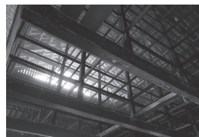
▲主屋の天井部分の「小屋組」
