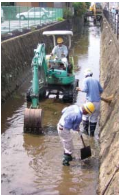
重機を使って行われた河川清掃（伊豆長岡地区）
