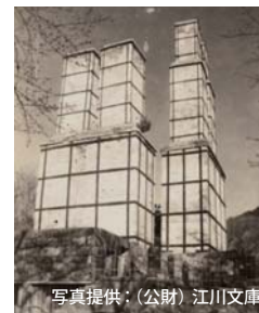
写真提供：(公財)江川文庫 昭和5年(1930)北伊豆地震による北炉最上段崩壊
