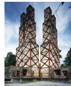
昭和32年(1957)北炉最上段復元と鉄の筋かい補強後
