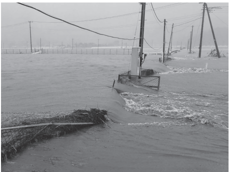
▲ 奈古谷排水機場付近(冠水)
