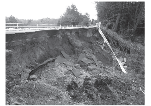
▲ 大 212 号線（着工前）
