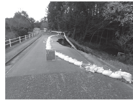
▲ 大 212 号線（着工前）
