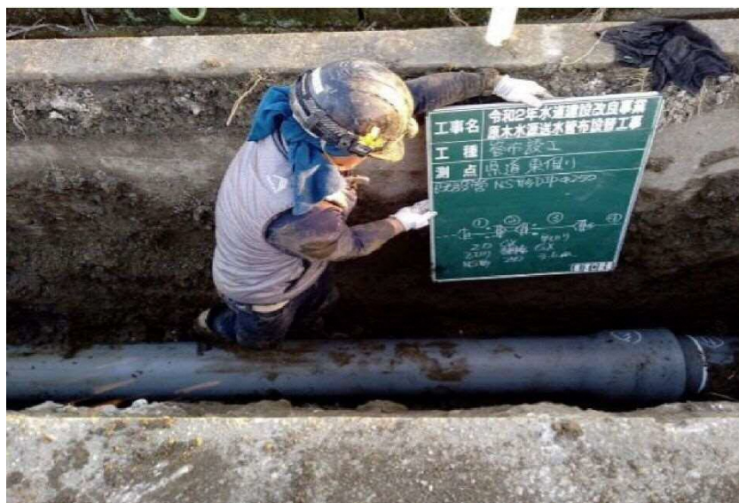
老朽管更新工事の様子
