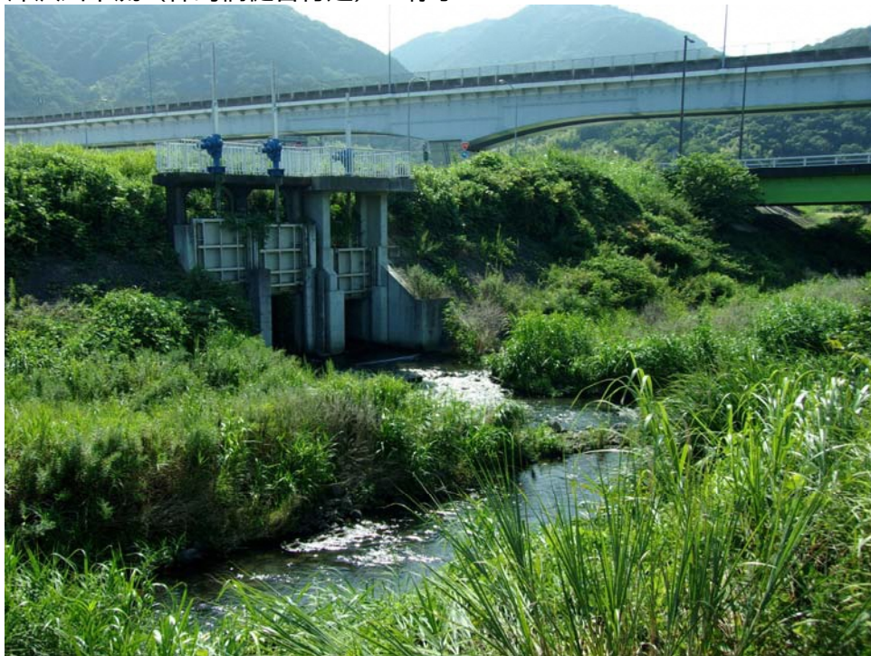
深沢川下流（神島橋樋管付近）の様子
