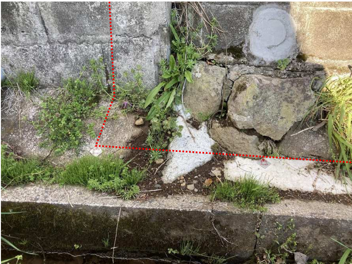
北西角に境界標識(金属標)
