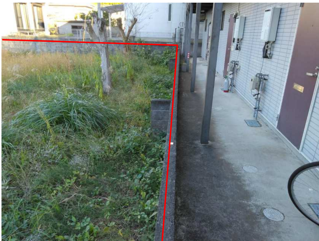
南側ブロック塀(共有工作物)
