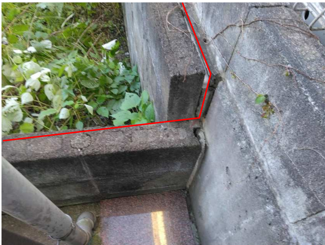
南東角に境界標識(金属標)
