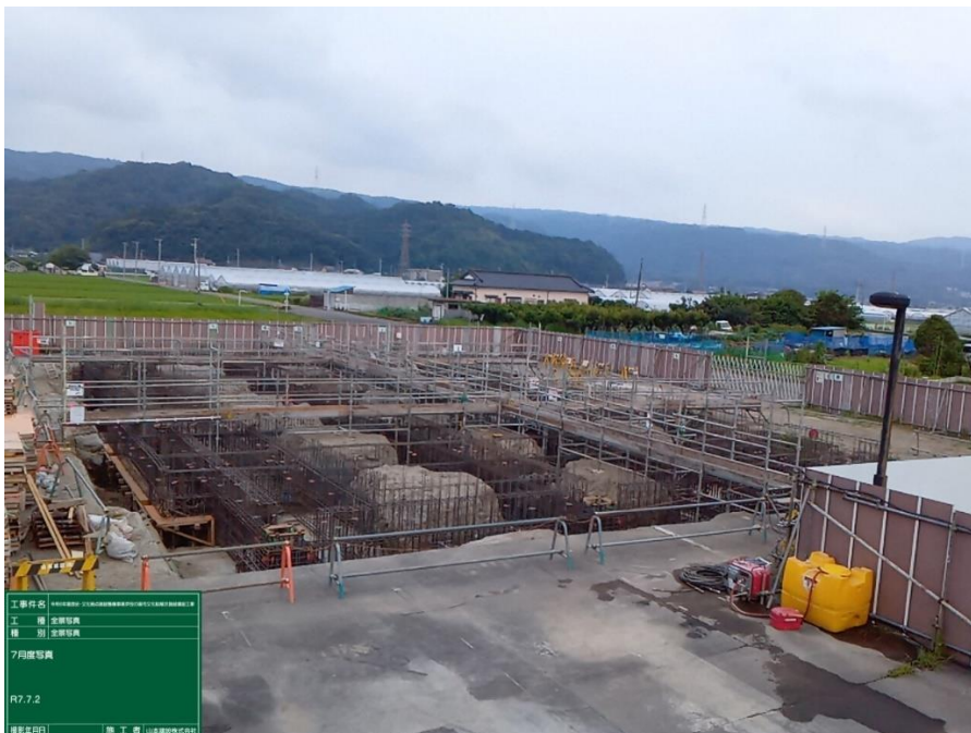
○基礎・地中梁 配筋 全景
