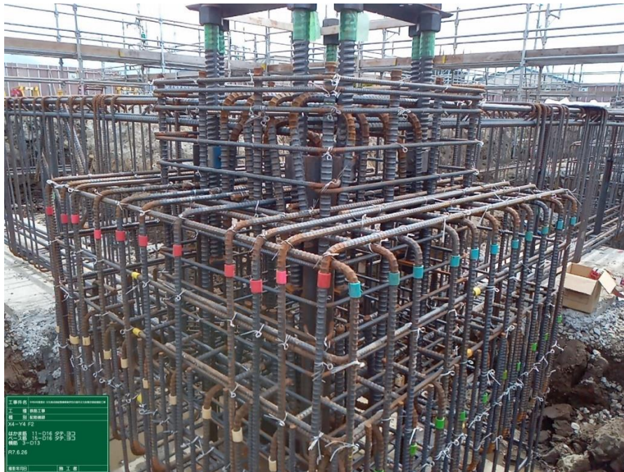
○基礎・配筋状況
