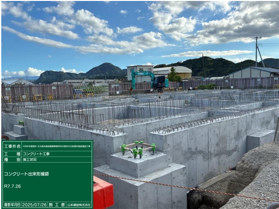
○コンクリート打設後 型枠脱型 コンクリート出来形 全景
