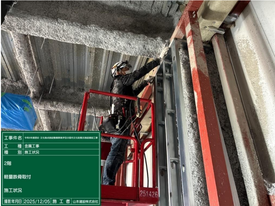
○軽量鉄骨取付 状況
