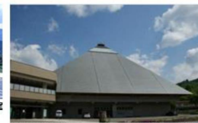
大湯温泉交流センターユピオは大湯公園内にあり、体育施設や多目的展示室を備える。第三セクターが指定管理者となり運営を行っているが、経費負担も多いことから、施設の有効活用に向けた附帯機能等を協議予定。
