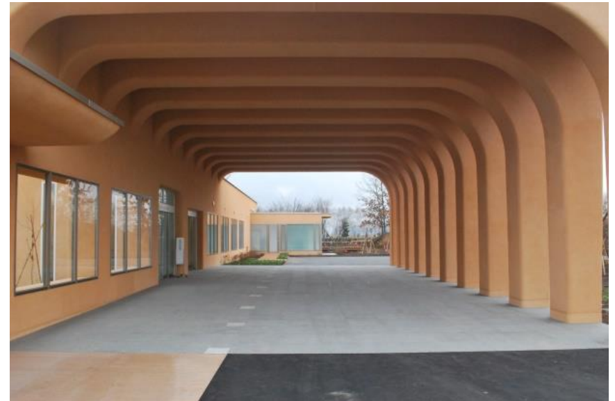
段差が無くフラット化された床(音更町火葬場)
