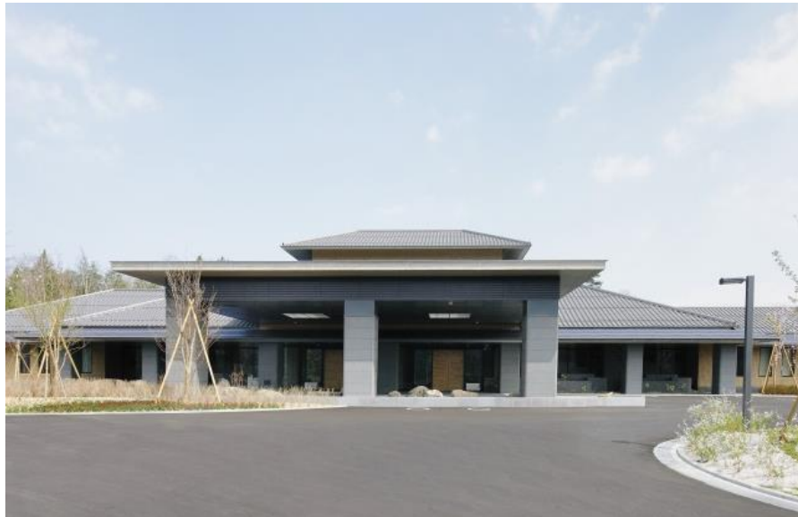
大屋根方式とした車寄せ(三次市斎場)
