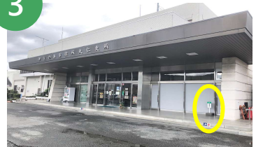
市役所大仁支所
