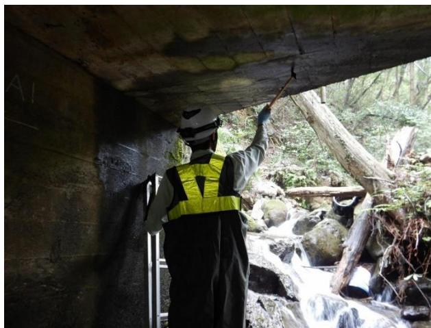
林道南奈古谷線（無名橋）
