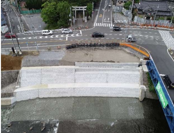
工事名:右岸下部工工事 技術者:日吉 英則(土屋建設株式会社 所属)
