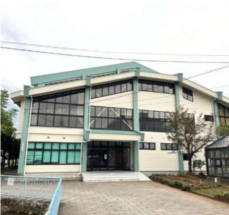
工事名:韮山小学校屋内運動場屋根及び外壁改修工事 受注者:株式会社佐藤建設 伊豆営業所
