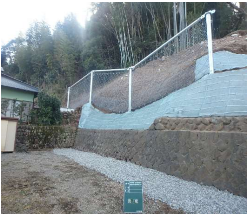
工事名:浮橋古根急傾斜地工事 技術者:石山 慎一(株式会社共進土建 所属)
