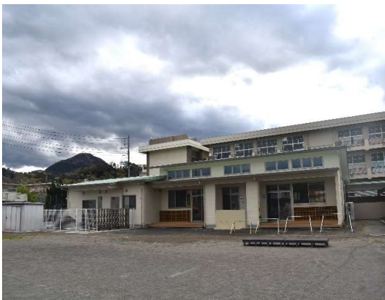
工事名:(仮称)長岡こども園整備工事 受注者:山本建設株式会社 伊豆の国営業所
