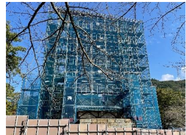
修理工事着工中の葦山反射炉 (令和3年10月)
