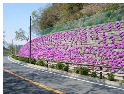
沿道の擁壁の修景
