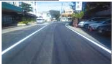
L=460m舗装工事の実施状況
