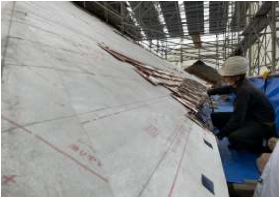
江川家主屋保存修理における 屋根の葺き替え施工の様子
