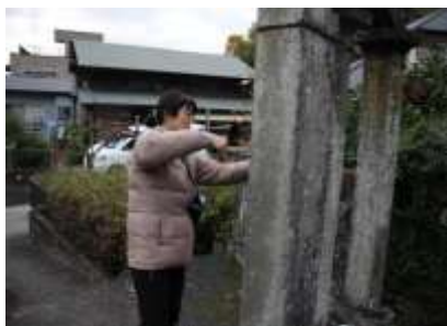
建造物調査 香山寺山門
