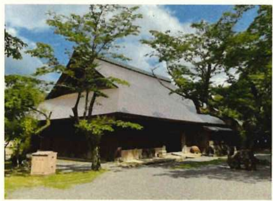
江川家住宅主屋(屋根工事完了後)
