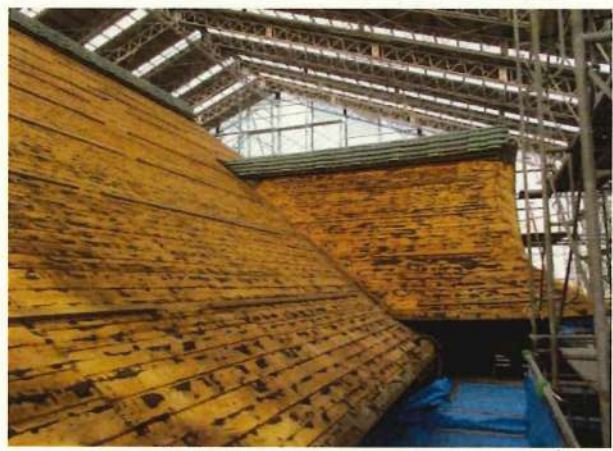
重文 江川家住宅建造物保存修理事業(主屋銅板葺解体)
