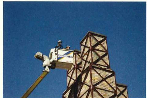
高所作業者による目視調査
