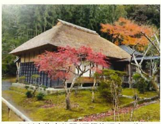
江川家住宅仏間(屋根修理完了後)
