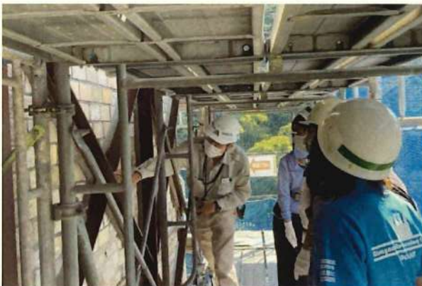
葦山反射炉保存修理工事 工事説明会
