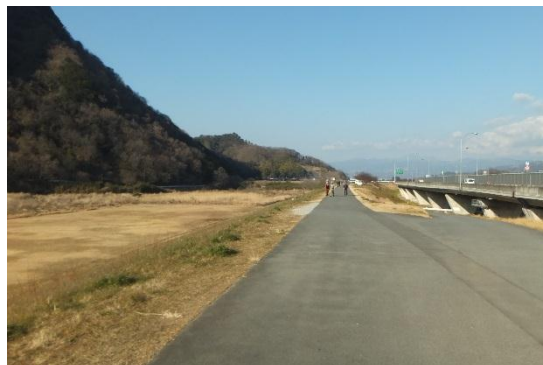
②中間付近
