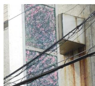
プラケット下に汚ダレが見られると、内部の取付金具にサビや腐食の可能性がある。
