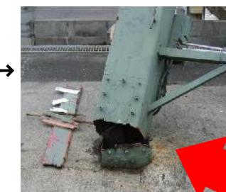
折れた柱の根元。点検口のボルト穴からサビが入り腐食して、鉄骨が破断した。
