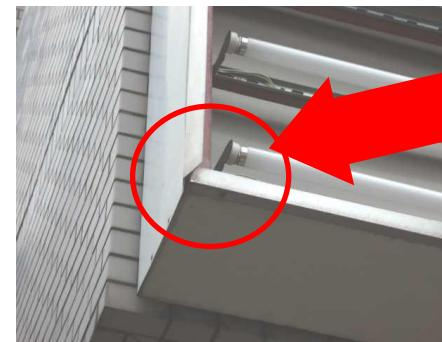
←パネルの変形、ズレ、破損の他、パネルの押さえ枠が変形し落下する場合も。
