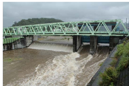
狩野川放水路
