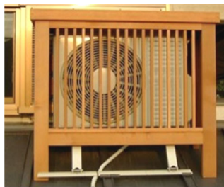
エアコン室外機カバー
