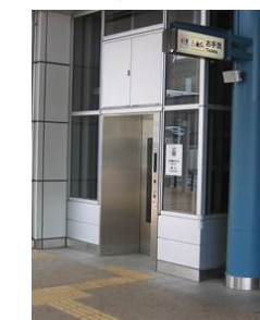
エレベーターや音声誘導装置の設置
