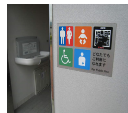
多機能トイレの設置
