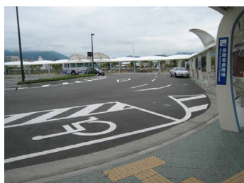
障がい者用の乗降口の設置
